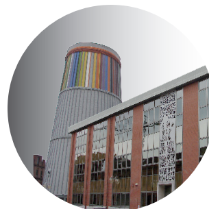
Edificio Sede Polígono Valnalón - La Felguera
