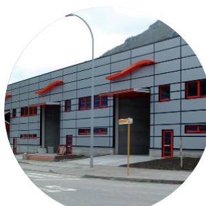
Naves Caudal Polígono de Baiña - Mieres
